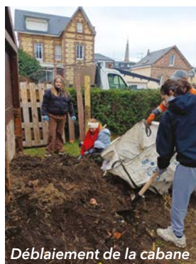
Déblaiement de la cabane
