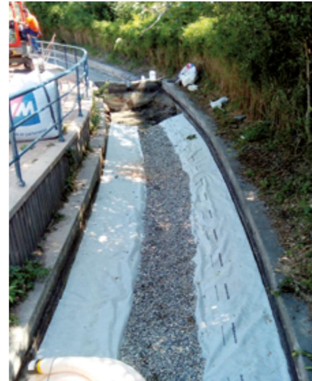
Ouvrage longeant le chemin des Remparts réalisé il y a près de trente ans, le canalet de la porte de l'Eure présentait des signes de vieillissement qui ne trompaient pas. Alimenté en partie par les écoulements des eaux du réseau routier voisin, les dépôts étaient importants et empêchaient la bonne circulation de l'eau (voir photo ci-dessus), des lentilles d'eau colonisaient ainsi la surface pouvant créer une illusion (d'optique) de continuité de l'espace vert adjoignant, entraînant des chutes.
