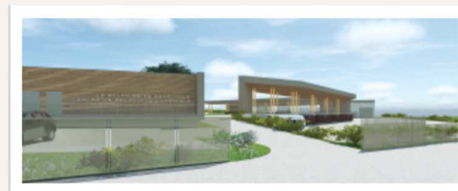
CDR moderne Propreté du site + Vidéo-protection du site et des abords
