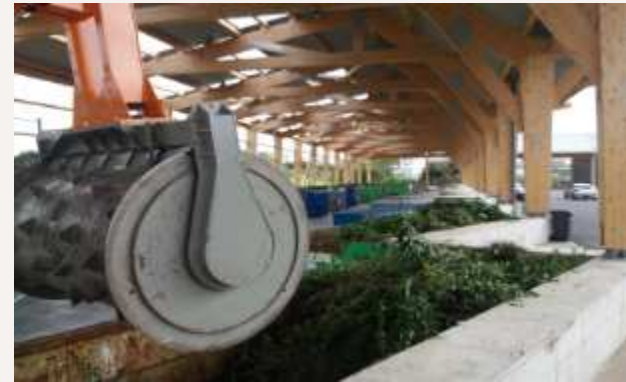
Compaction de benne pour optimiser les rotations
